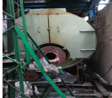
**FOTO 4. CALDERA 50 BHP EN INSTALACIÓN**
